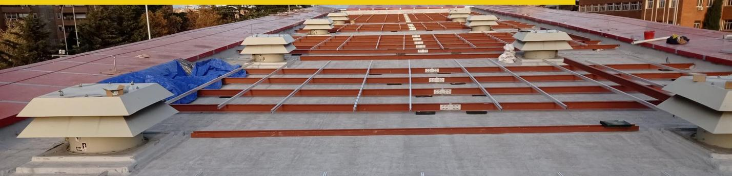
Soporte coplanar continuo fijación a correas para cubierta de teja
