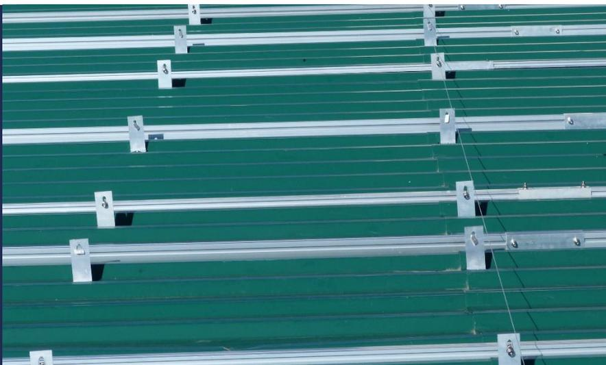
Con esta estructura coplanar de Sun Support se garantiza la óptima incidencia de la radiación solar para la producción fotovoltaica. La instalación cuenta con un total de 252 módulos y una potencia de 70,56 kWp.
