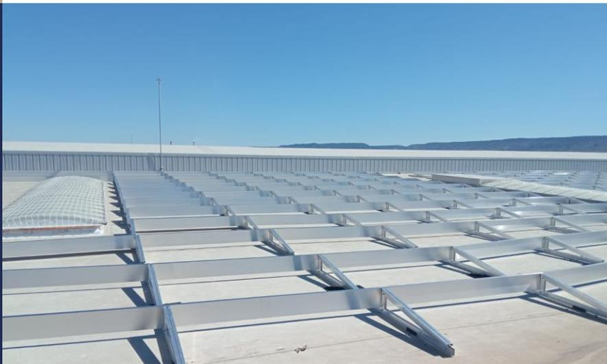
En esta ocasión se ha apostado por el modelo de estructura inclinada triangular continua "Sierra Nevada" de Sun Support. Esta estructura es utilizada para fijar una gran cantidad de módulos FV en superficies planas de grandes dimensiones.
