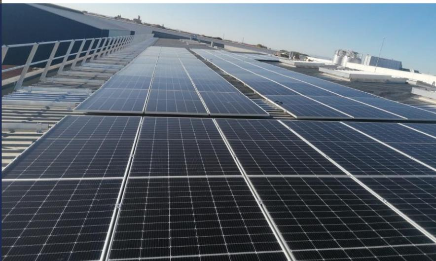
Las estructuras coplanares son estructuras sin inclinación añadida. La instalación cuenta con un total de 320 módulos y una potencia de 100,8 kWp.
